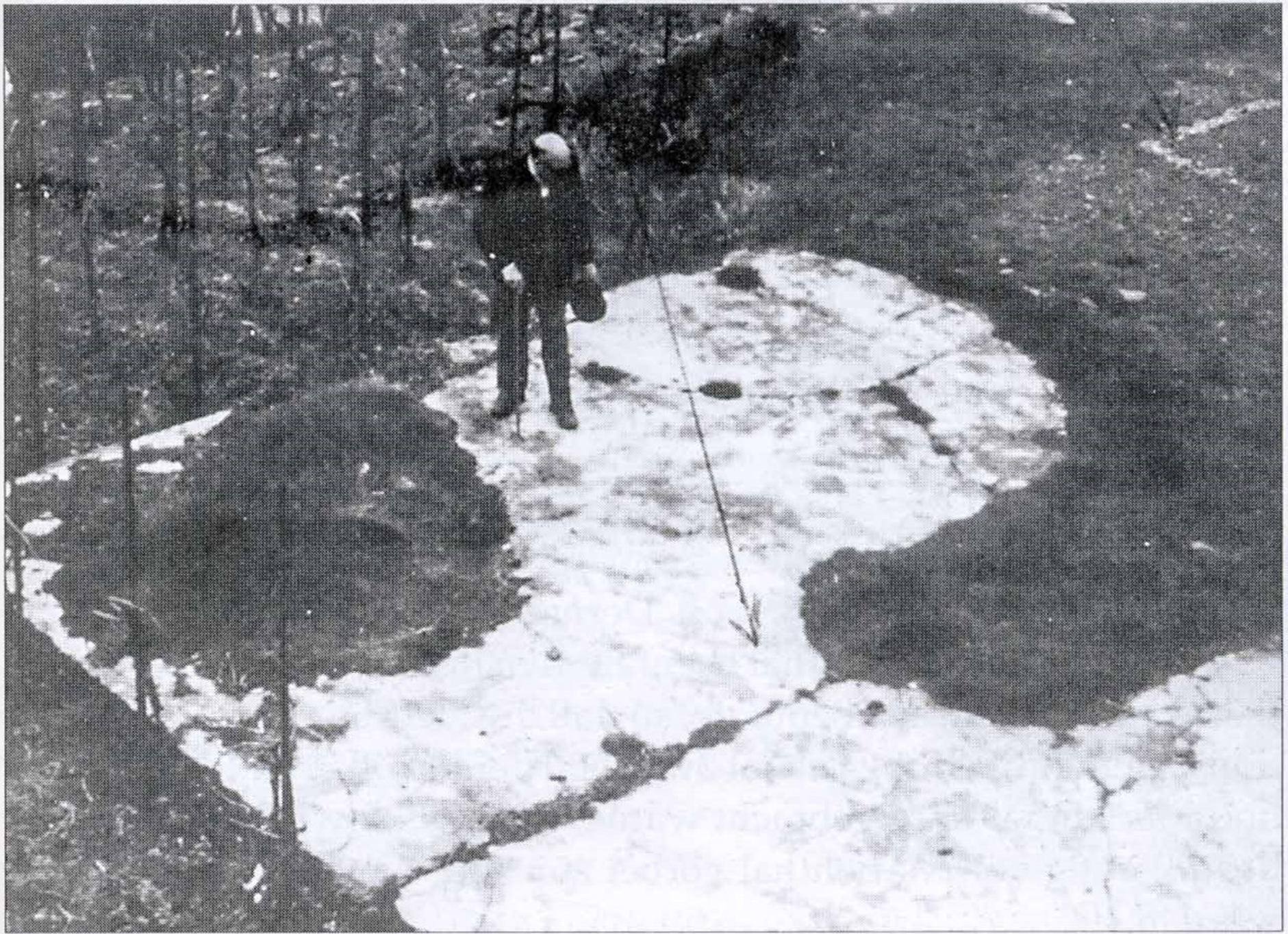
Fundamente und Bodenplatten des Lagers »Rebstock« sind noch deutlich zu erkennen. (Foto: Staatsanwaltschaft Koblenz, 101 UJs 268/86. 1986)
